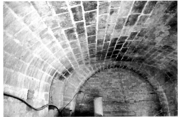
Foto 10. – Volta i arc toral del sector occidental de la galeria nord (Servei d'Audio-visuals de l'IEI).
