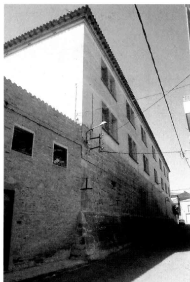
Foto 8. — Façana nord-occidental i cantonada septentrional (Servei d'Audio-visuals de l'IEI).
