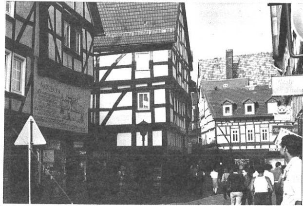
Alsfeld después de la restauración
