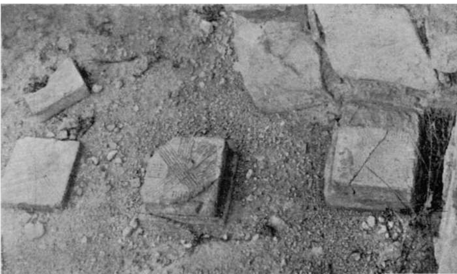
Restos de las pilastras de ladrillo del hipocausto
