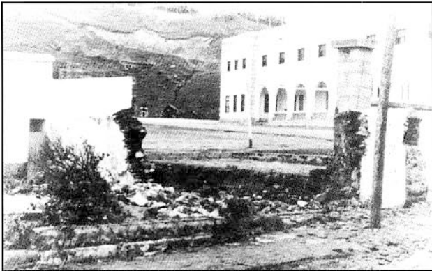
Riada del martes 13 de enero de 1970. Muro roto en la guardería. Al fondo el cuartel de Infantería de Marina. (Foto: Archivo particular de Jesús Terán)
