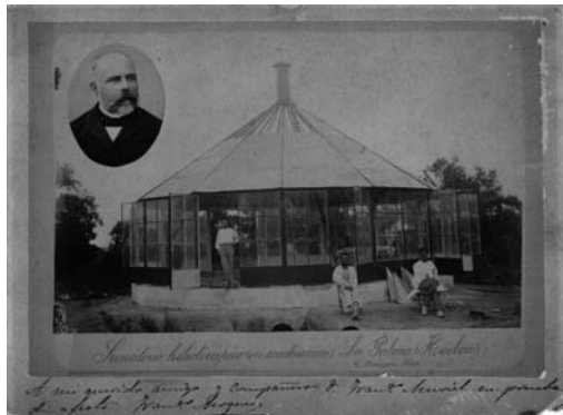
Fig. 4. Sanatorio Helioterápico (en construcción) La Palma (Huelva). Foto dedicada por D. Francisco Moguer al médico D. Francisco Muriel. (Cedida por la hermana de éste, Dña. Josefa Muriel de La Palma del Condado, Huelva. Se ha encontrado también esta misma foto en la biblioteca de D. Francisco Moguer)
