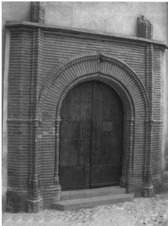
Figura 14. Portada de la Capilla después de la restauración
