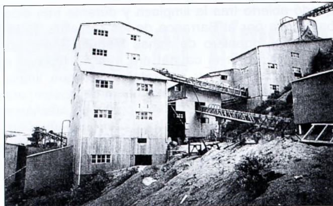
Vista del lavadero, tras su clausura.
