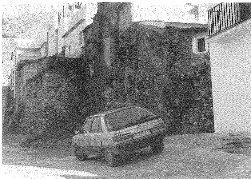
Arches. Restos de muros. Lado norte.
