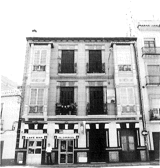
Fachada actual del bar El Caracol
