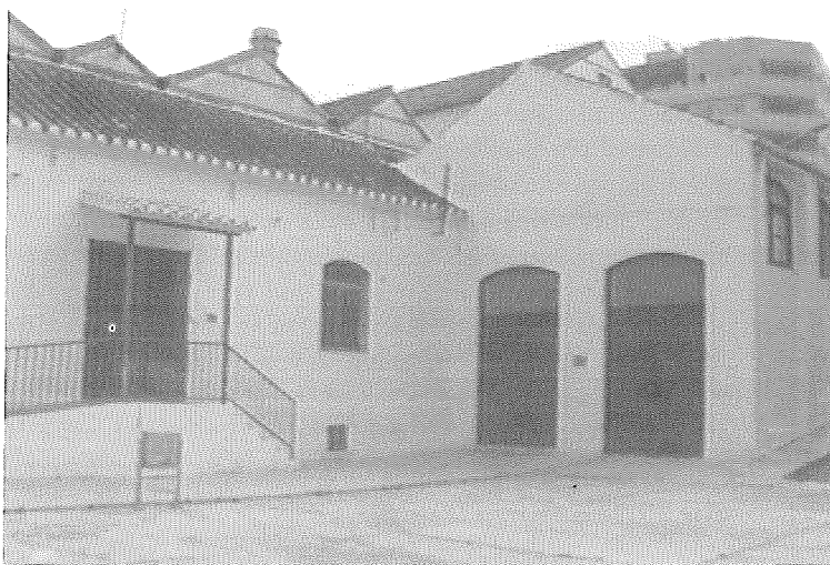
6. A la derecha, las dos puertas de entrada al salón de actos. A la izquierda, la entrada al gimnasio, antes almacén de carga del azúcar. Obsérvese la rampa elevada usada para cargar los sacos en los carros y camiones. 2002.
