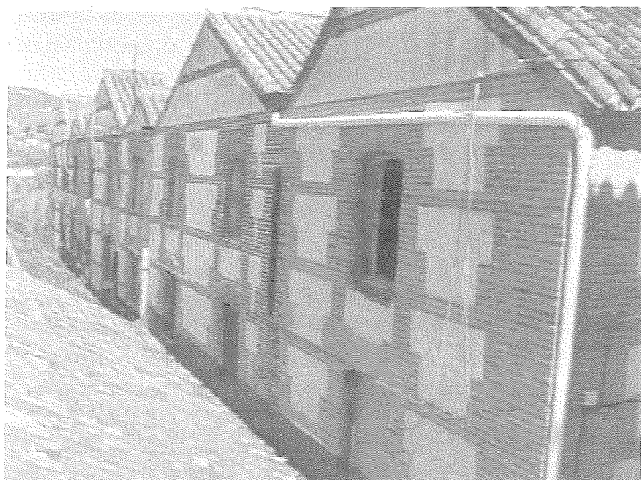
5. Fachada sur de la nave de talleres (secaderos de azúcar). Junto a ella, se observan los tejados de la nave de la melaza, actual salón de actos. 2002.
