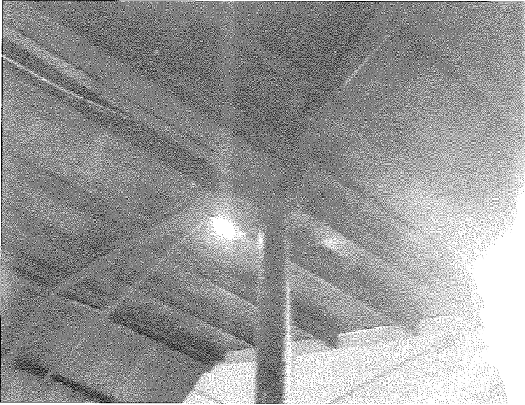
7. Armadura de hierro fundido y techumbre de madera de la antigua nave de melazas, hoy salón de actos. 2002.
