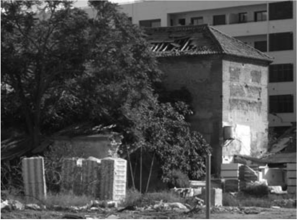
Nave del refectorio tras su demolición parcial (foto R. Marín).
