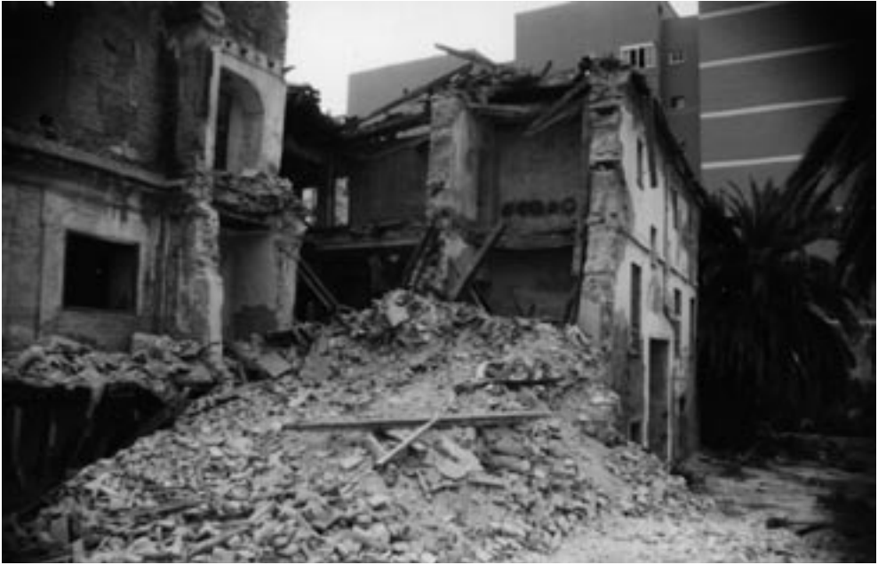
Estado de la demolición iniciada en 1999 (foto R. Marín).
