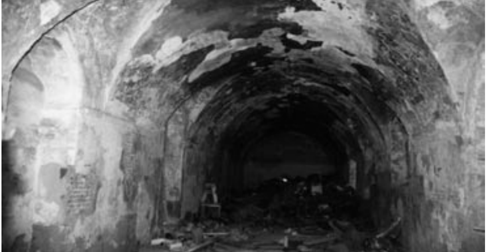
Interior del refectorio del convento antes de su demolición parcial (foto R. Marín).
