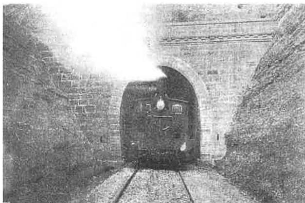
Salida del túnel cerca del Samper de Calanda en la línea de FF.CC. de Val de Zafán.
