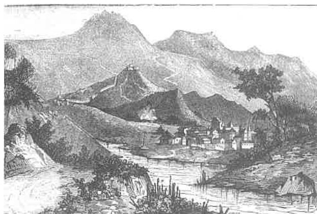
Vista de los Puertos de Beceite.
