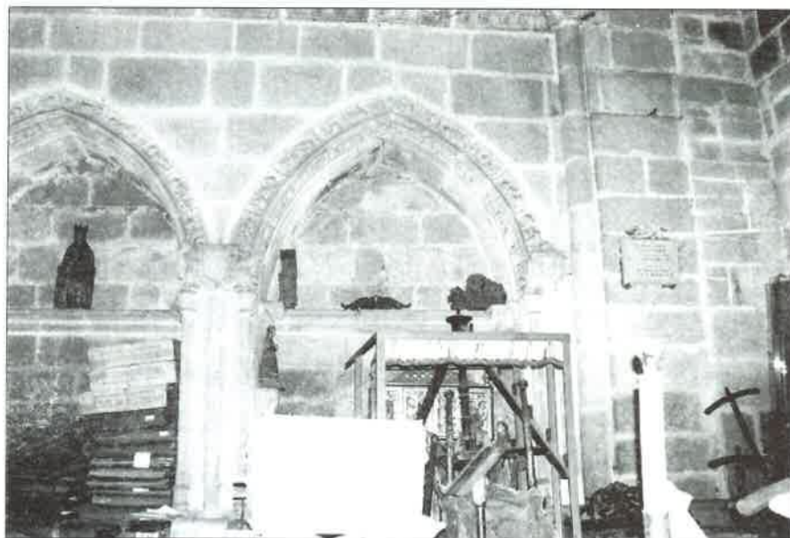
Fig. 33: Paramento interior del muro norte de la capilla de San Juan en la Catedral de Orense, arcos 5 y 6.
