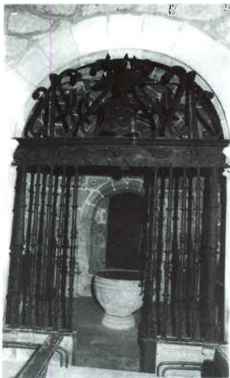
Fotografía N° 3. Capilla del Capitán Punxín, Iglesia de la Valenzana. Entrada desde el interior de la iglesia.
