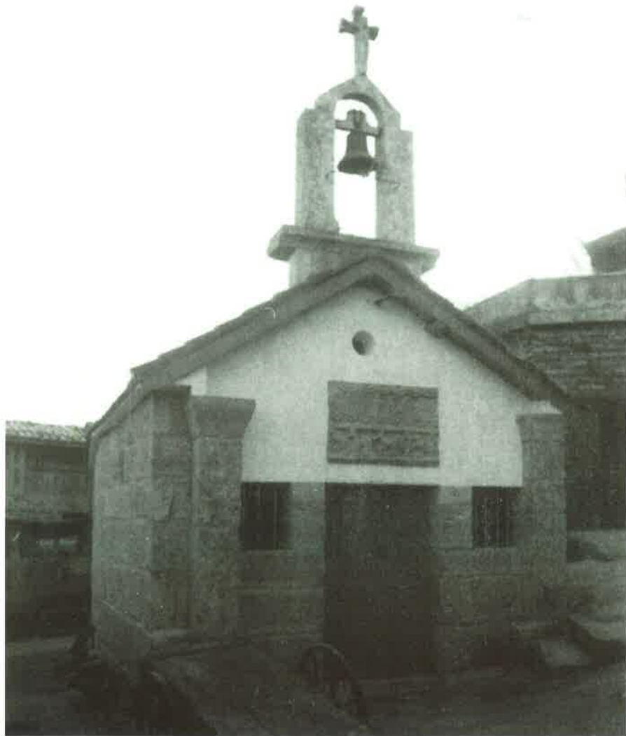
Fig. 1 Vista xeral da capela de O Formigueiro
