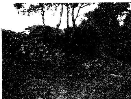
FOTO 9: Estado inicial del torreón de la cerca exterior.
