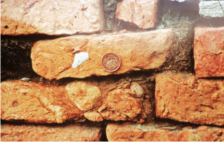
Fotografía 10- Imagen microscópica de un ladrillo de Innismurray con inclusiones de arenisca autóctona de la zona.
