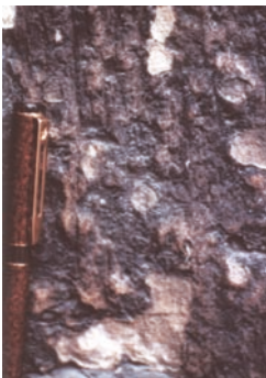
Foto 4- Costras negras en la fachada norte de la concatedral de Santa María La Redonda de Logroño. Ampollas y escamas.
