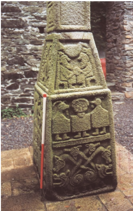
Fotografía 17- Granito de Leinster de la Cruz de Moone (Irlanda) totalmente colonizado por algas.
