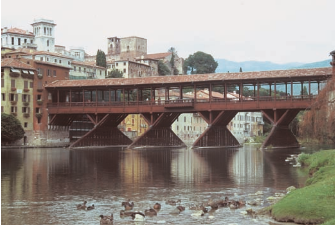
Fig. 8: Ponte Coperto de madera en Bassano del Grappa (Italia) obra de Andrea Palladio, destruido durante la Segunda Guerra Mundial y reconstruido por Ferdinando Forlati tras la contienda. Foto: Óscar Reinares, Agosto 1998.
