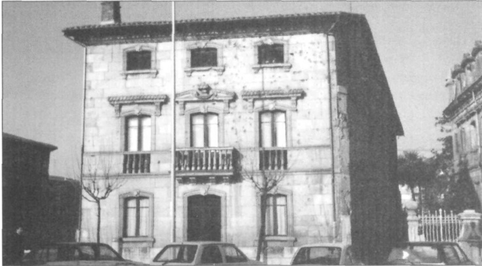
Lámina 19. Edificio nº 11 de Kurutziaga Kalea.
