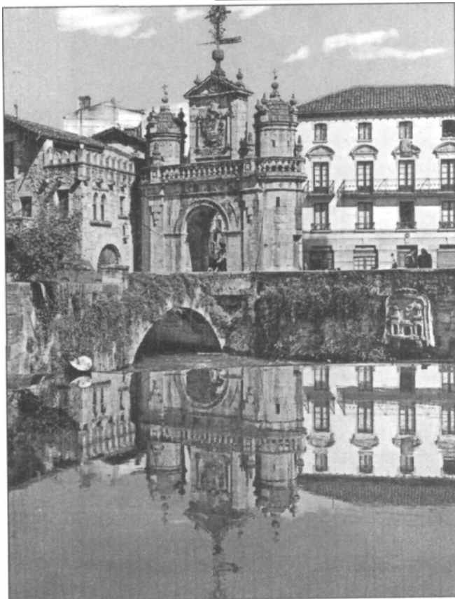
Lámina 6. El río Mañaria encauzado entre las fachadas posteriores de Uribarri Kalea y Zumalakerregi Kalea.
