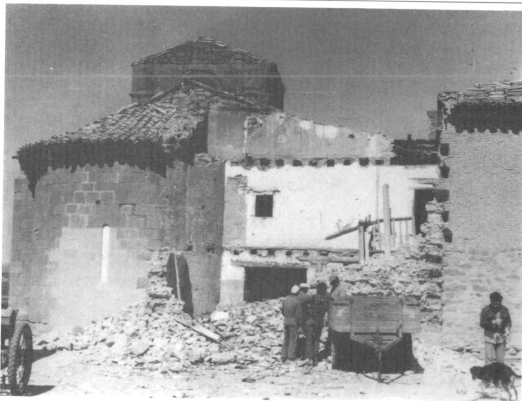
Derribo del edificio adosado.
