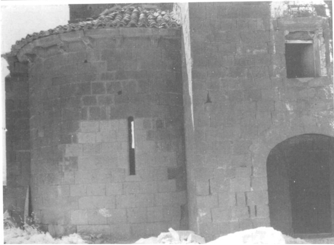
Ábside antes de derribar el edificio adosado.
