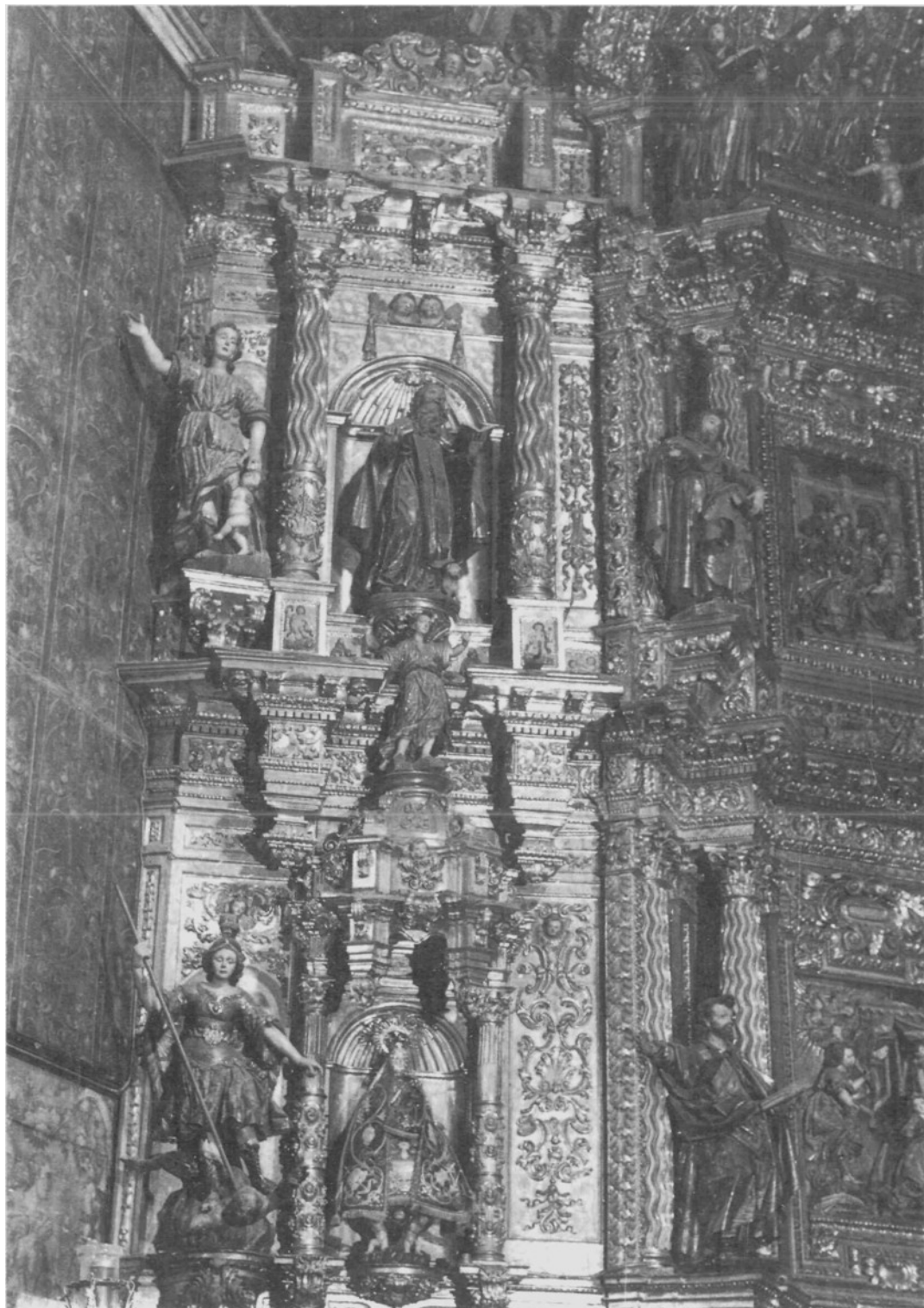
«Creencia» afectada por el desprendimiento de la bóveda en la Navidad de 1830.
