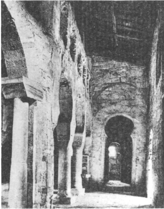
Fot. 3 La actual nave derecha. En un segundo plano se aprecia el arco de ingreso a uno de los espacios abovedados. Al fondo el arco falso que lo comunica con la estancia suroriental.
