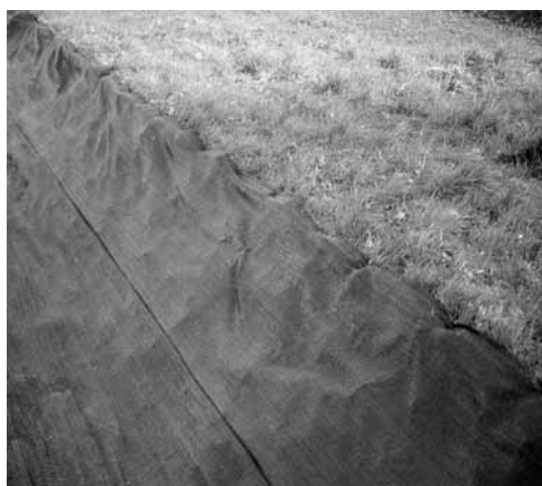
Fig. 16 Sítio arqueológico de São Marcos: trabalhos de cobertura das valas onde as estruturas arqueológicas se encontravam implantadas e posterior selagem das mesmas com areia de rio e terra vegetal.
