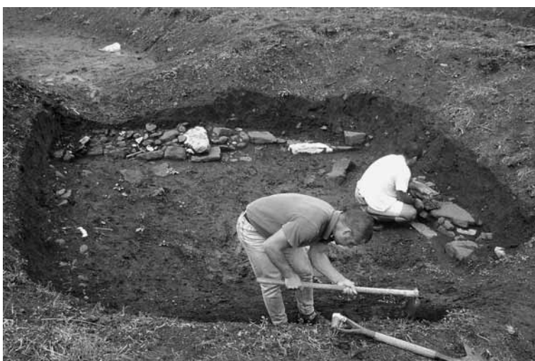
Fig. 6 Trabalhos de limpeza das estruturas existentes no terreno.
