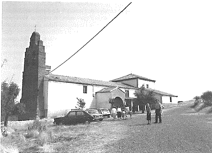
Iglesia de San Cipriano (Foto: "Estudio fotográfico Benito". Valderas. León).
