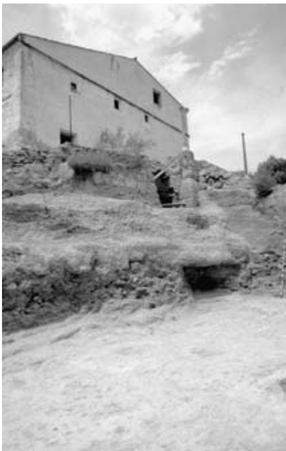
Fig. 11. Detalle de la pequeña cavidad excavada en las margas y debajo de las gravas para evitar la escalada de la pared. Se aprecia el tramo excavado; por seguridad se ha mantenido su relleno en el resto del trazado (J. I. Rodríguez, Servei d'Audiovisuals del IIE).
