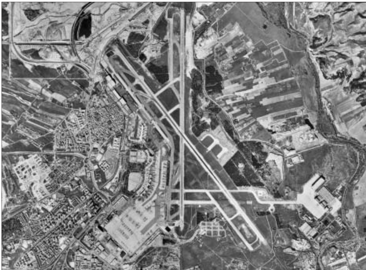
FIG. 8. Arriba, aspecto que presentaba el Aeropuerto de Madrid-Barajas en 1998, cuando comenzaban las obras de construcción de la tercera pista, tal y como se puede deducir del movimiento de tierras visible en la parte superior de la imagen (mosaico formado con las ortoimágenes II-II y II-IV de la Hoja 559, pertenecientes al SIG Oleícola). En la página siguiente, a la izquierda, detalle del sector donde se ubican las Terminales; la Internacional (T1), la Nacional (T2) y la de Carga (T3); también se pueden ver en la parte inferior de la imagen las obras del Dique Sur (DS) destinado a la ampliación del servicio de la Terminal Internacional (fragmento de la ortoimagen 1: 5. 000 del IGN, hoja 559). A la derecha, aspecto que presentaba a comienzos de los años 80 la Zona Industrial nº 2 de Iberia, construida desde comienzos de los setenta al sureste del Aeropuerto, en las inmediaciones del río Jarama, ocupando los terrenos de lo que a lo largo de varios siglos fue la explotación agroganadera de La Muñoza (vid. FERNÁNDEZ GARCÍA, 2005); la imagen recoge un fragmento del fotograma 637 de la pasada 28 del vuelo realizado por CETFA para COPLACO el 5 de octubre de 1980, siendo la escala aproximada del original 1: 18. 000.
