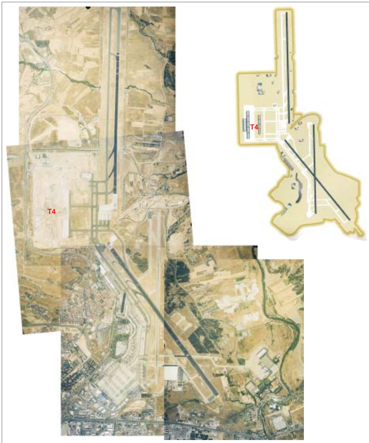
FIG. 11. Estado en que se encontraban las obras de ampliación del Aeropuerto (Plan Barajas) el 22 de julio de 2001; a la izquierda del arranque de la nueva pista 18-16, ya plenamente operativa, se ven las obras del nuevo Edificio Terminal (T4). Este mosaico no controlado se ha formado con los fotogramas 2401, 2398, 2274 y 2181 del Vuelo de la Comunidad de Madrid, a escala aproximada de 1: 20. 000 (Archivo de la Comunidad de Madrid). Arriba, a la derecha, esquema de la configuración del aeropuerto tras la inauguración de la tercera pista en 1998.
