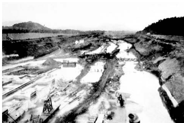
Imagen No. 1: Obras de construcción del Canal
