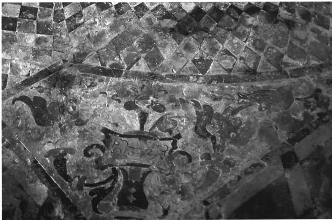
8. Detalle del mosaico del suelo del Pabellón de Carlos V. Ángulo derecho próximo a la entrada, con la cartela que contiene la fecha de terminación del edificio, 1546.
