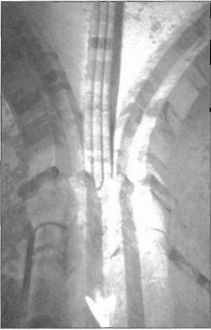
Pilar del crucero, enjarje de nervios y cola sobre el pilar
