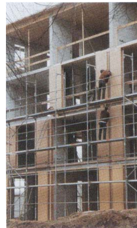
La estructura portante es de hormigón armado, las fachadas de madera.
