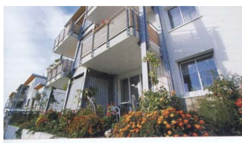
Fig. 2 Acceso a un bloque de viviendas
