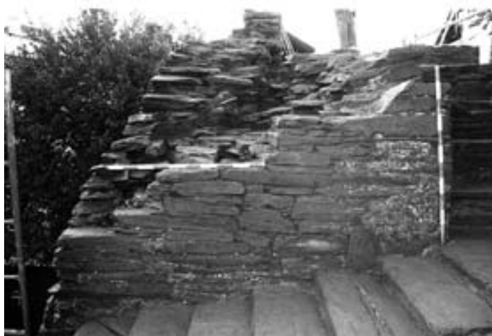
Vista interior de una escalera original. Escalera Cubo LIV Cubo LXXXI
