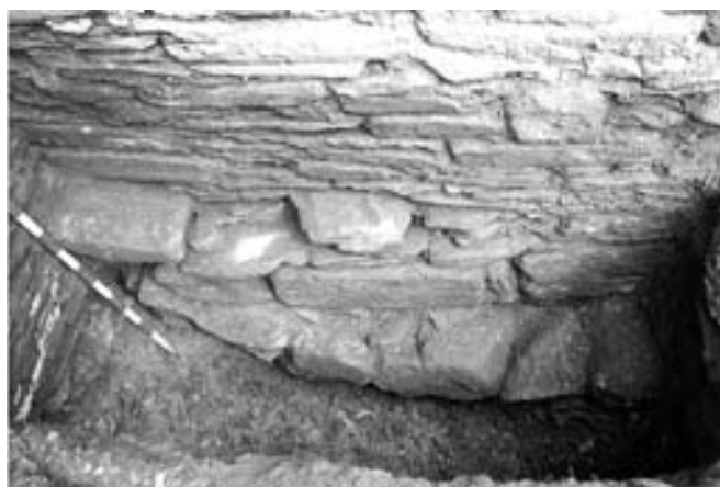
Cimentación de piezas de granito.
