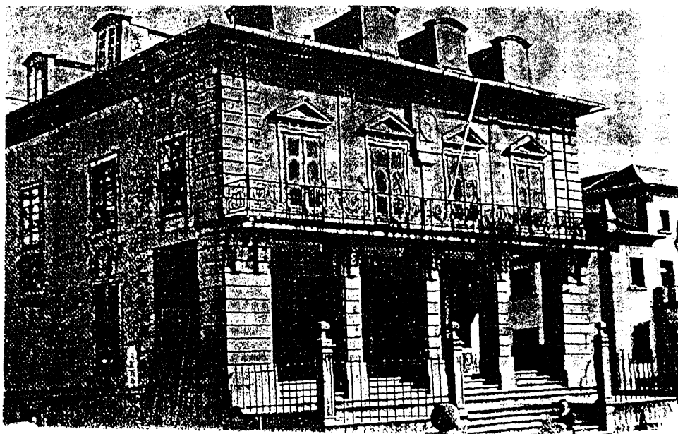
Palacio de Ibáñez en Ribadeo, actual Ayuntamiento
