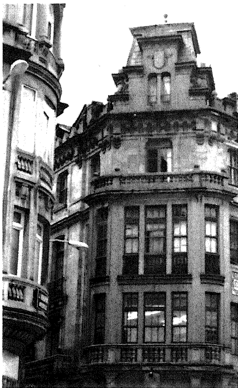
Vista del chaflán del edificio.
