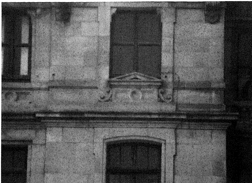
Colocación manierista de los frontones, no habitual en este arquitecto, bajo las ventanas del ático.
