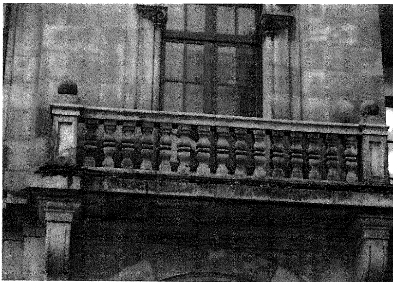
Balaustrada de piedra del primer piso que recuerda la tradición autóctona; columnillas y recercado barroco flanquean las ventanas.
