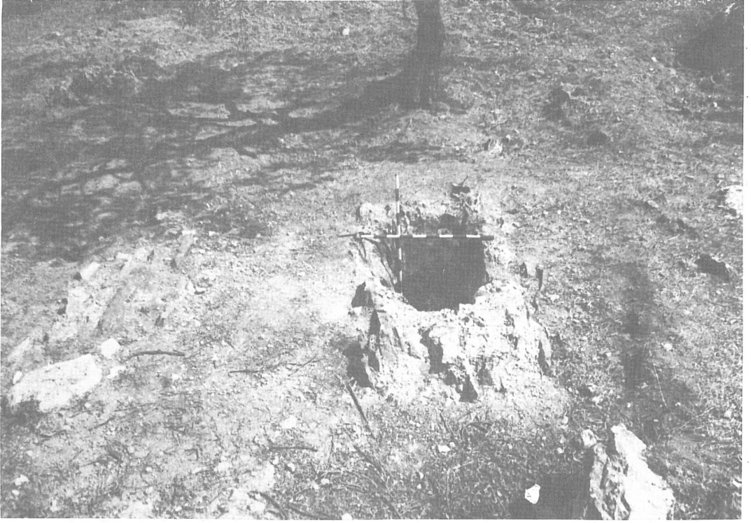
Boca exterior del aljibe
