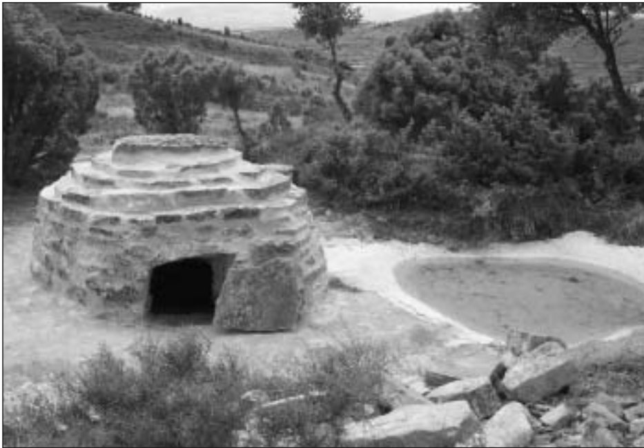
Aljibe de la sierra de Azuelo ya restaurado
