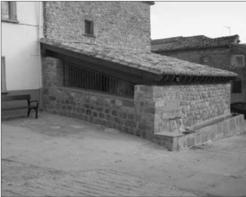
El lavadero ya restaurado
