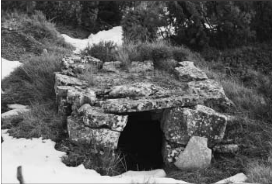
Aljibe de la sierra de Azuelo antes de su restauración
