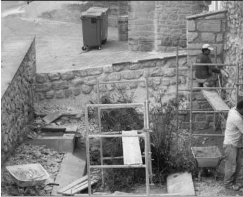
Lavadero de Azuelo en obras
