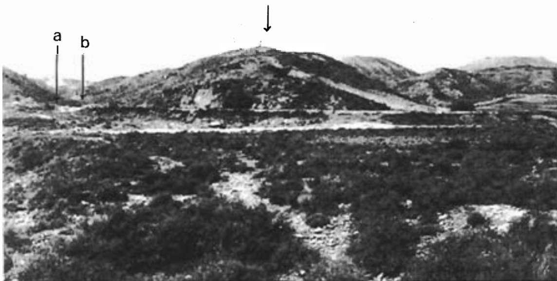
Fig. 16. Barranco de San Jorge I. Situación general. Situación de la presa (a). Trazado de la vía (b).
