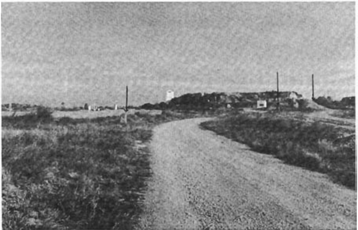
Fig. 10. Vía. Tramo III. Instalaciones de la planta de gravas.
