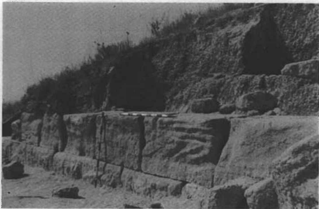
Lámina 4. — Vista del muro incrustado en la ladera oriental.
