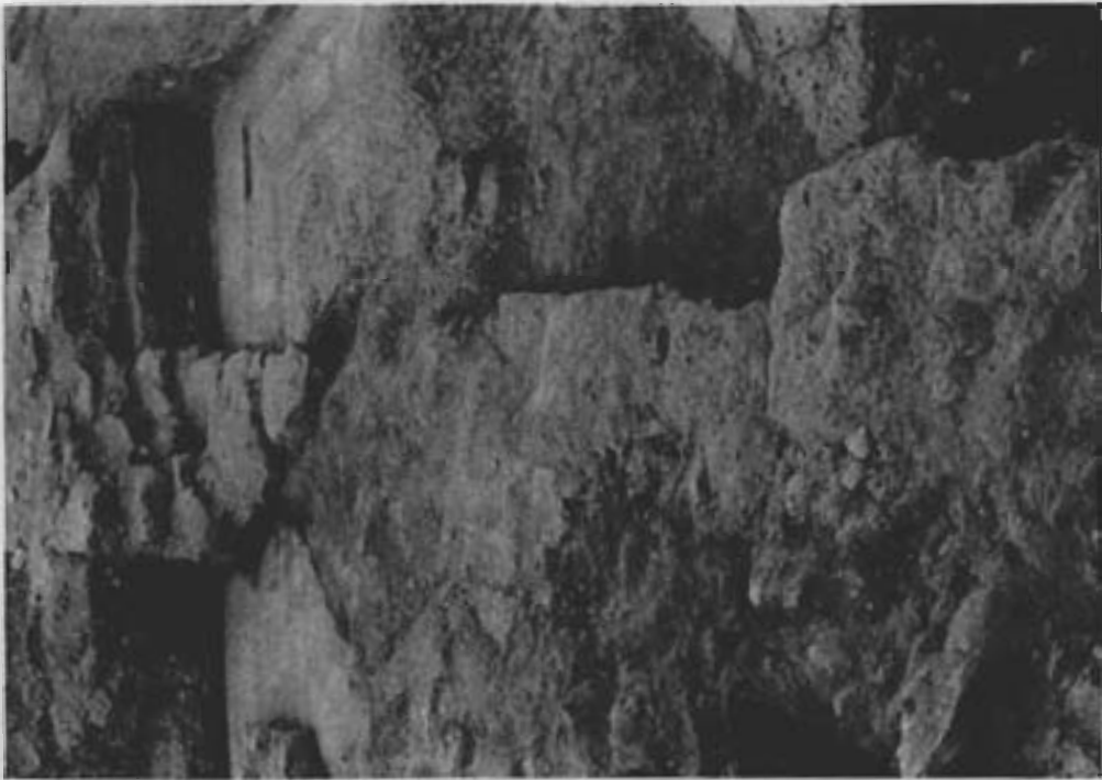
Lám. 1.1. Uno de los muros del Antiguo Hospital Provincial que cimentaba directamente sobre el mosaico.
