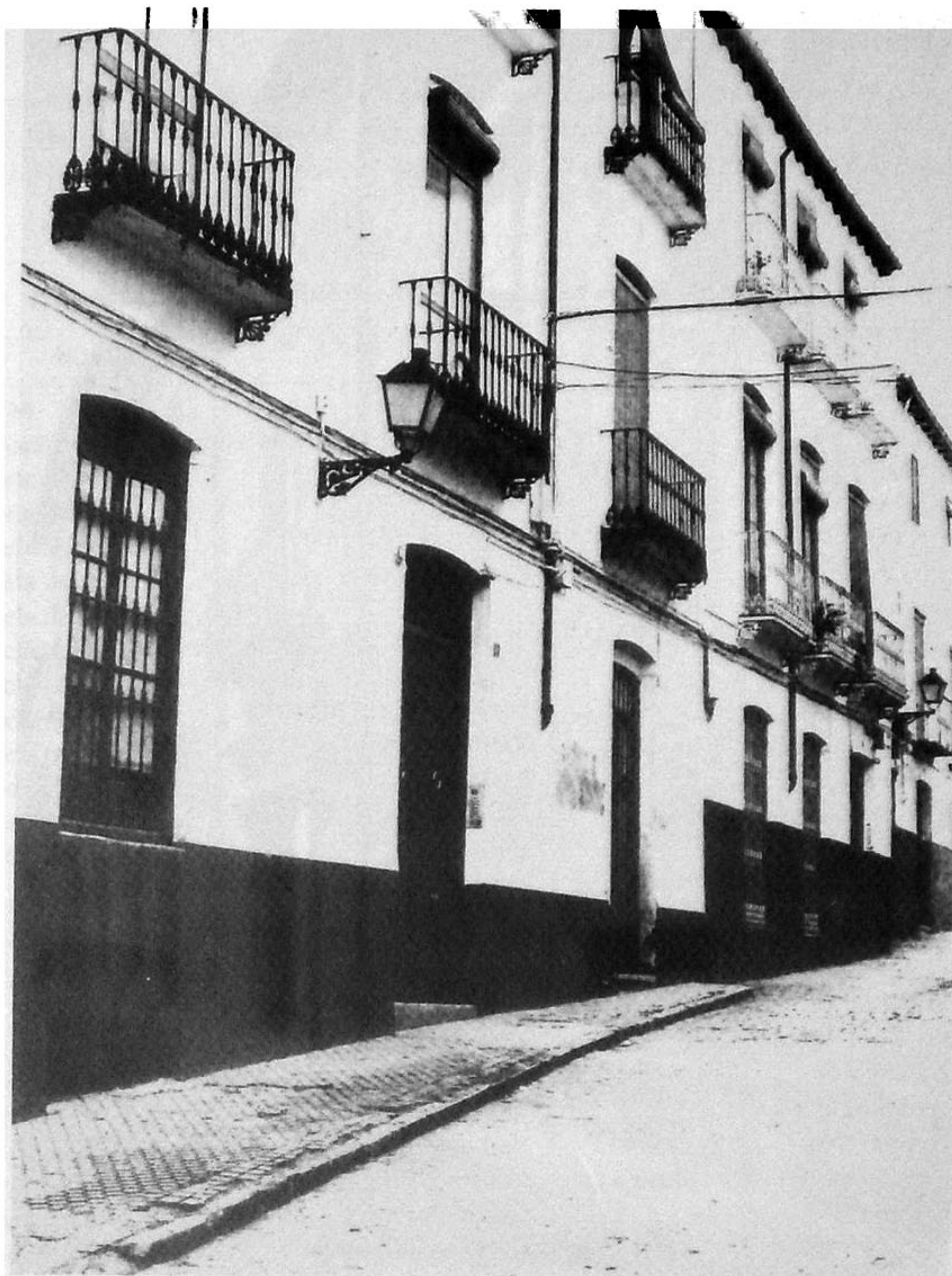
Aspecto actual de la casa que ocupó la Escuela Normal de Maestros de 1923 a 1932.
