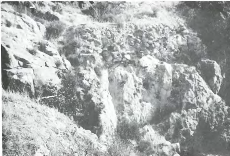
Dos aspectos de las fortificaciones del Zumel: calicanto en tapiales con mucho relleno de cantos rodados y mamposterías en los zócalos que sostienen la obra del aljibe. (Juan Eslava Galán, 1979).
