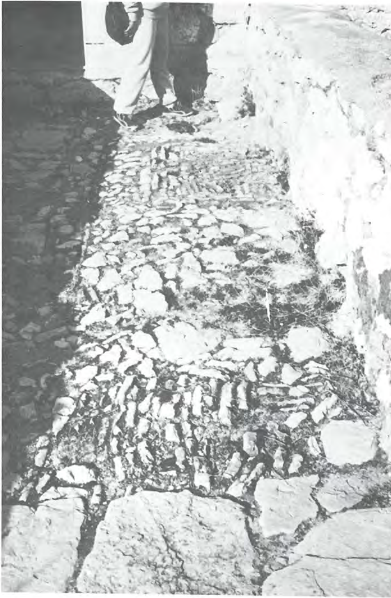
Detalle del empedrado del patio de armas del castillo de Abrehuí, en los alcázares de Jaén: losas irregulares, ladrillos de canto y acanaladuras para aprovechar el agua de la lluvia que iría a los aljibes. (Juan Eslava Galán, 1984).
