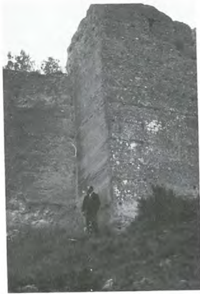
Torreón de la muralla almorávide de Jaén. Su forma ligeramente troncopiramidal es característica de la fortificación almorávide más arcaica, así como la composición terrosa con alternadas lechadas de cal que caracteriza el núcleo, según observamos en otros torreones derruidos de este sector. (Juan Eslava Galán, 1984).
