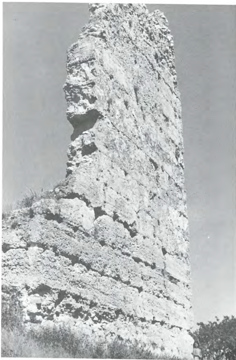
La Torre Bermeja o Torre de Pero Codes, en las proximidades de Jaén, al pie de las Peñas de Castro. Se trata de un curioso ejemplar de torre del homenaje musulmana anterior a 1246, construida en tapial de calicanto, con entreplantas de obra de madera. (Juan Eslava Galán, 1984).
