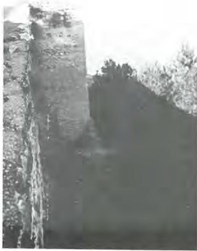
Torreón del alcázar viejo de Jaén. En la parte inferior se observa el resalte escalonado correspondiente a la primitiva alcazaba musulmana, de época califal. Sobre estos restos edifican los almorávides un cuerpo de tapial de calicanto que a su vez recibe un parapeto de mampostería correspondiente a una reparación de época cristiana. (Juan Eslava Galán, 1984).
