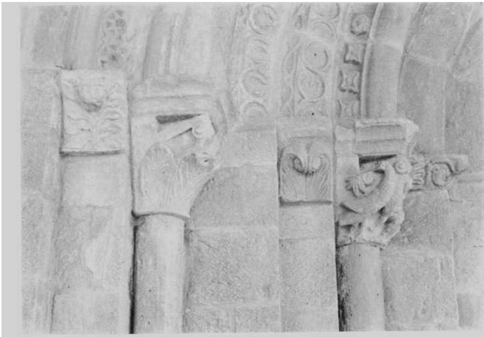
Foto 4.—Pórtico. Detalle capiteles izquierda.
