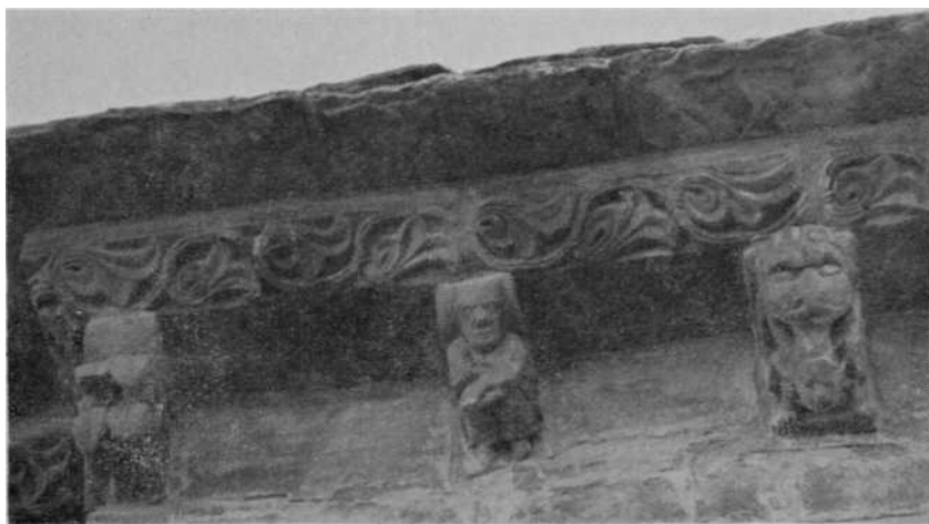
Foto 10.—Continúan los canecillos de la fachada norte.
