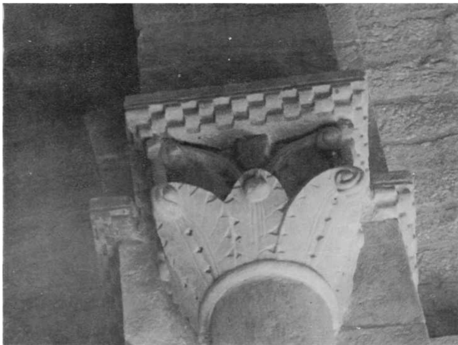
Foto 7.—Capitel del interior. Al fonco se aprecia el arranque del arco farmero.
