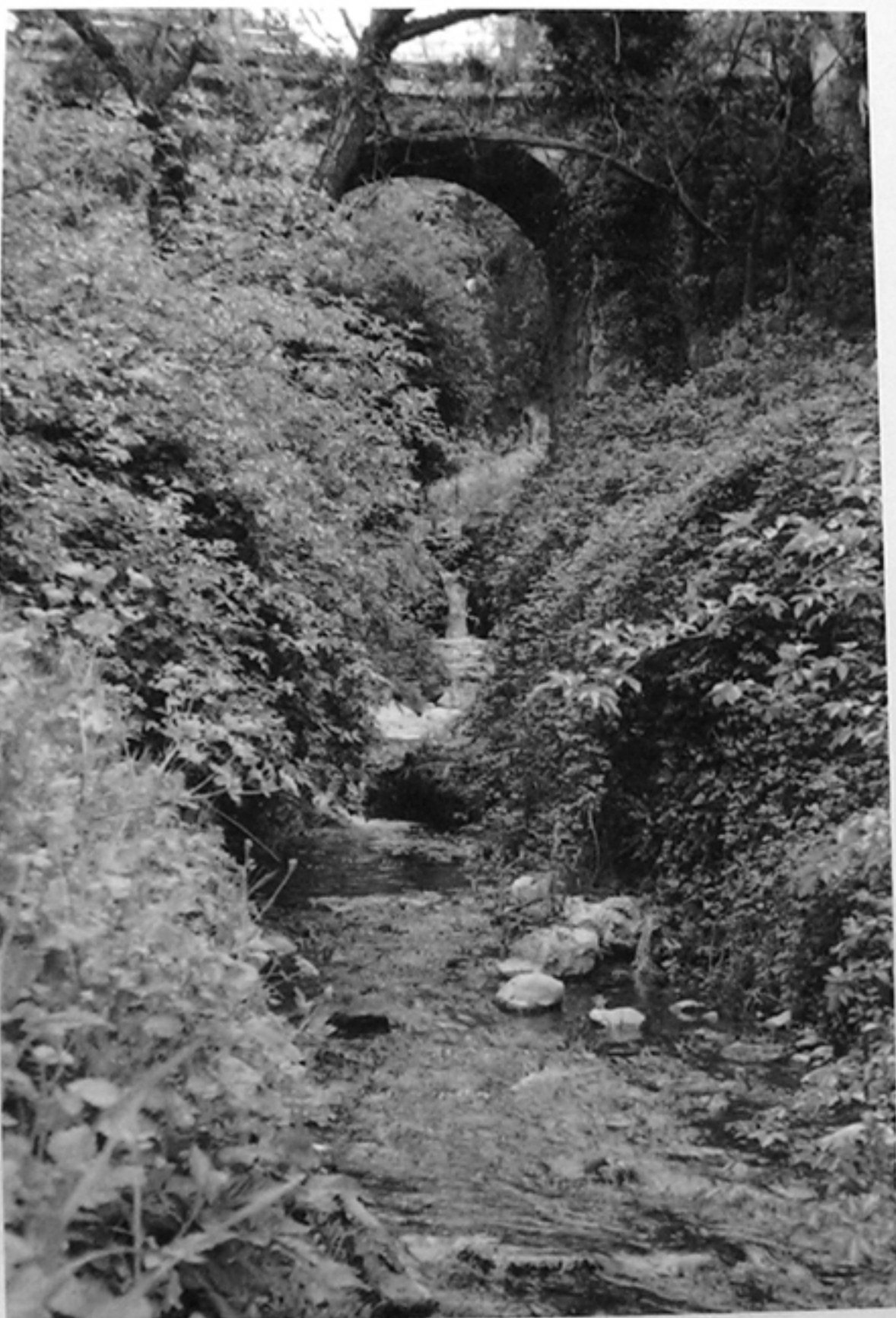
Arroyo de Navasequilla que atraviesa la población de Frailes y, al fondo, el puente.
