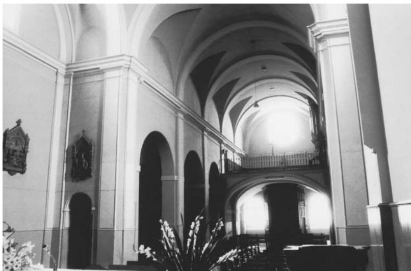
Fig. 14. Iglesia de Carmelitas Descalzos del Carmen. Interior. Zona de los pies.
