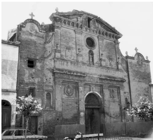
Fig. 5. Iglesia de franciscanos de San Salvador. Fachada.
