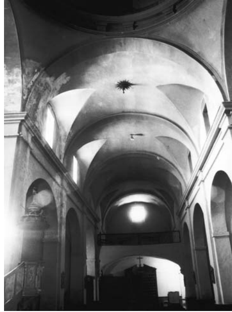
Fig. 4. Iglesia de franciscanos de San Salvador. Interior. Zona de los pies.
