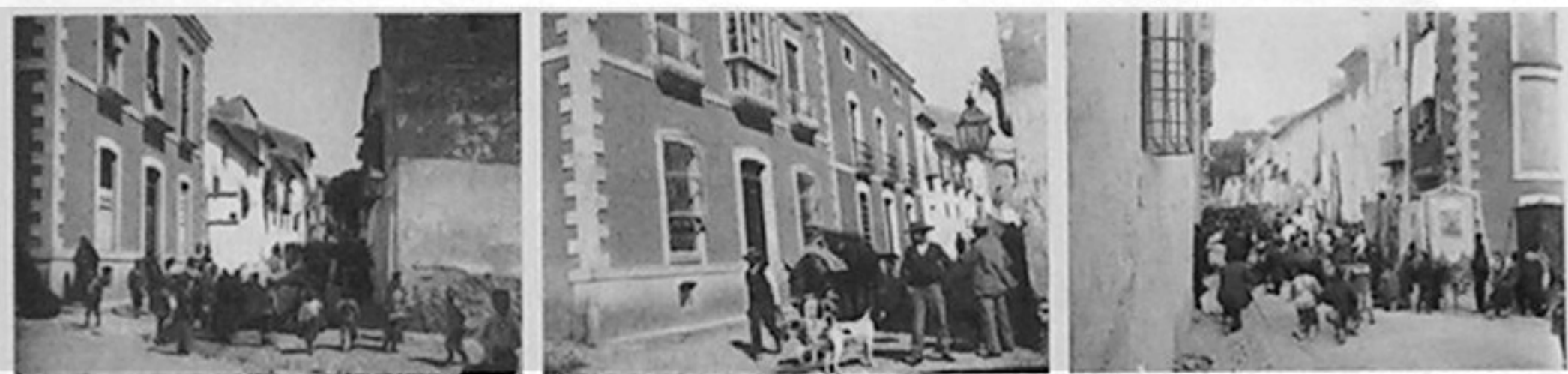
La casa de Cerdá y la aparición de las primeras casas regionalistas de Cabra del Santo Cristo una vez concluida ésta (1900-1904).
