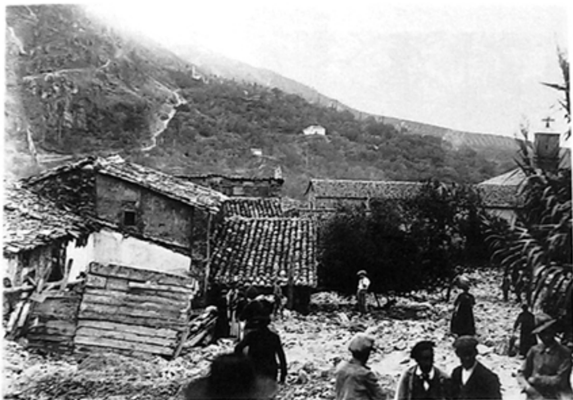
Corrimiento de tierras al final de la calle del Carmen debido a las inundaciones.
