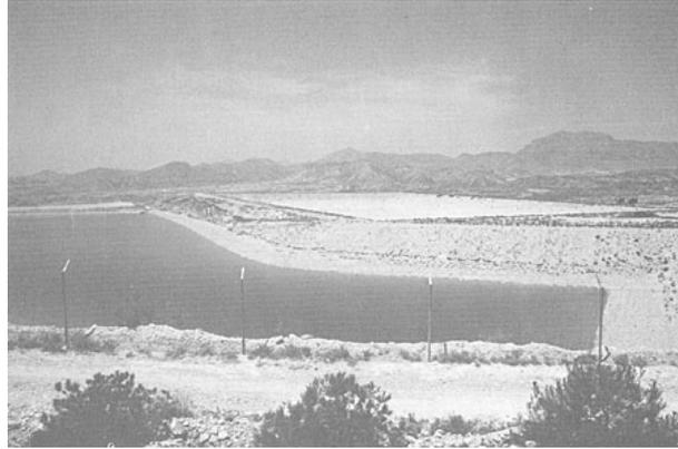
FOTO 7. Dos embalses de polietileno con capacidades de 1.400.000 m<sup>3</sup> el mayor y 60.000 el menor hechos aprovechando un Lambeaux de glacis de la Sierra del Cabeço D'Or. Esta utilización del resto de glacis es la que ha obligado a adoptar la forma irregular del embalse que se ve en primer lugar.
