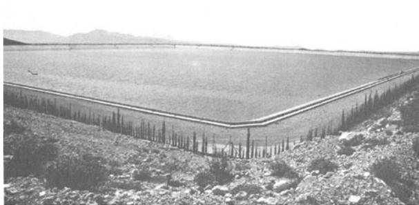
FOTO 4. Embalse de butilo de 600.000 m<sup>3</sup> de capacidad perteneciente a la S.A.T. de Monforte. Su vaciado se realizó sobre parte del glacis de la fotografía precedente. Desde él se inicia una red de canalizaciones que distribuyen las aguas entre los términos de Agost y Monforte. [49]
