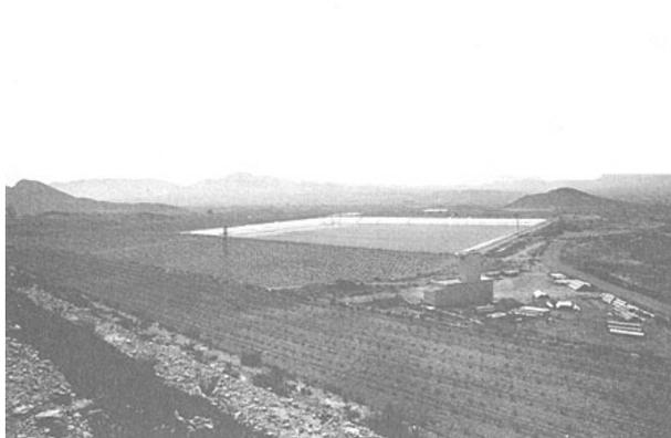
FOTO 5. Panorama de un embalse de butilo de 120.000 m<sup>3</sup> de capacidad en medio de un área transformada para el cultivo de uva de mesa. En primer término se ve el centro de bombeo de un pozo, que se utiliza para alimentarlo. Dicho embalse pertenece igualmente a la S.A.T. de Monforte.
