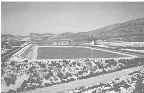
FOTO 6. Embalse de butilo de Agost con capacidad de 230.000 m<sup>3</sup>. Se aprecia claramente la técnica de su construcción, tanto del aprovechamiento de la topografía del glacis, como de los materiales del talud de la parte más baja y de la lámina de butilo que lo reviste. [50]
