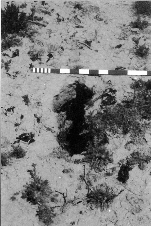
FIGURA 4. Ejemplo de piping, en el sector de Los Ventorrillos.
