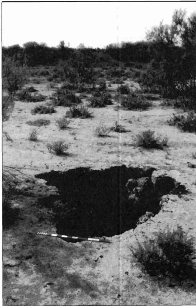
FIGURA 5. Ejemplo de piping en el sector de La Mata Norte.
