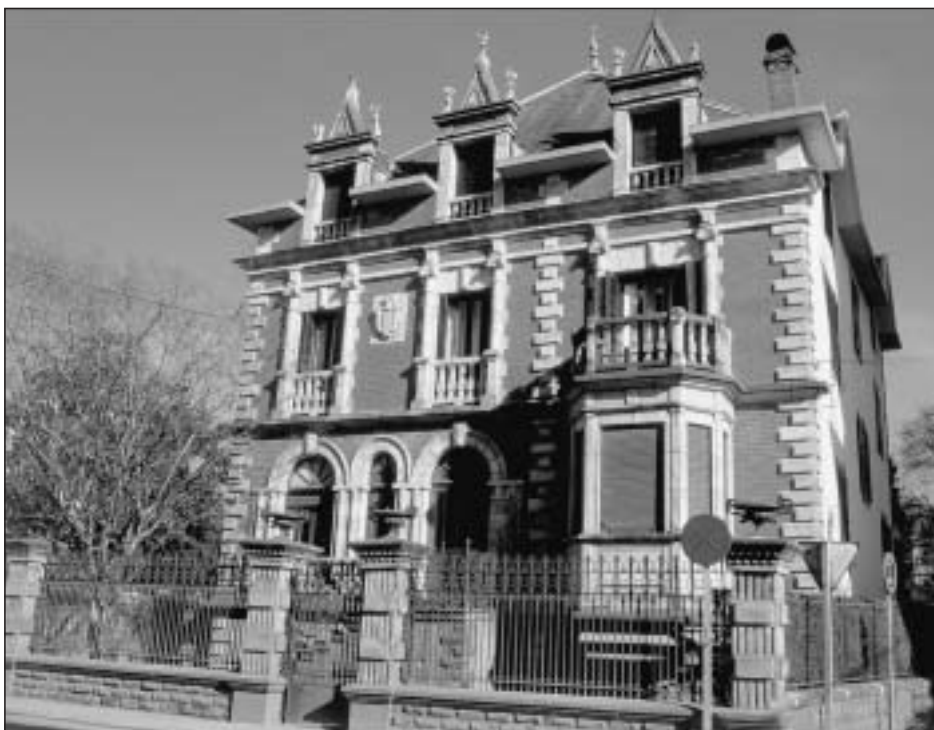
Lám. 12. Elizondo. Casa Manuelenea
